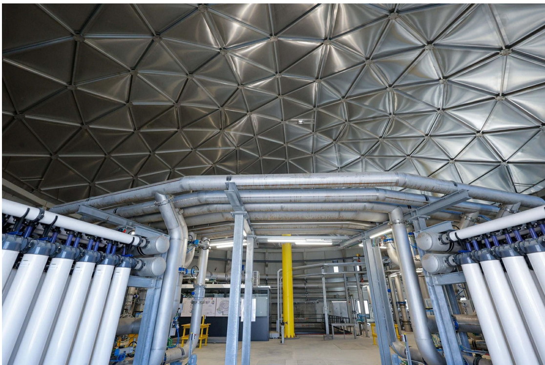
Imagen de la potabilizadora de O Casal tras las obras de modernización y ampliación.
